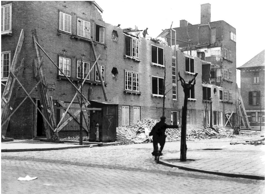
Slechte woningen aan het Ambonplein worden in 1936 gesloopt
